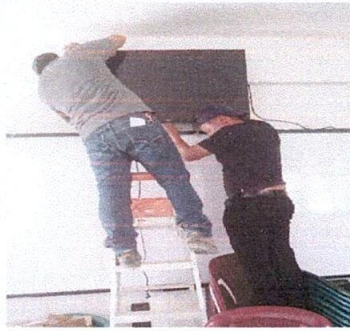
FOTO 3: Sustitución de instalación eléctrica en laboratorio de computación.
