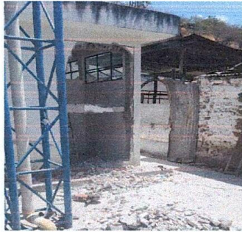
FOTO 1: Cambio de ubicación de puertas en servicios sanitarios
