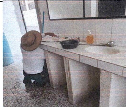
FOTO 4: Reparación de servicios sanitarios y sustitución de accesorios.
