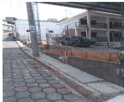
FOTO 6: Sustitución de muro perimetral sobre la 5a. Avenida.
