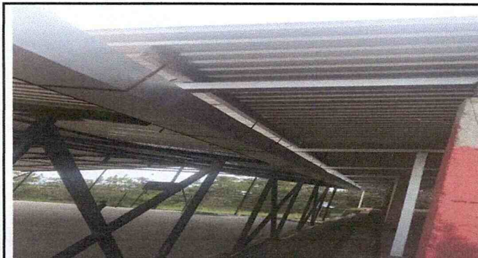
Foto 3: Canal y laminas y instaladas
