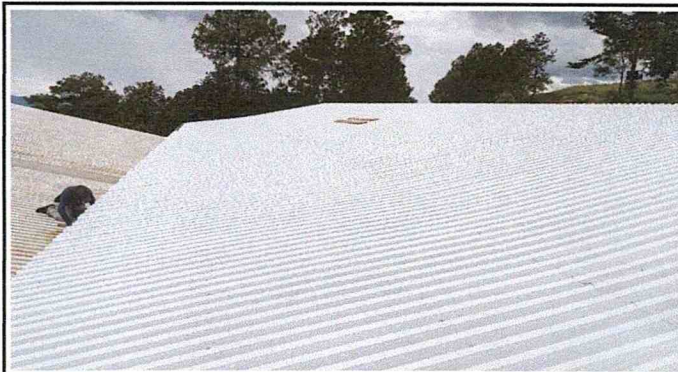
Foto 2: instalación de canal
