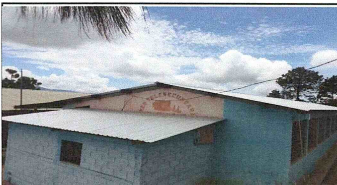
Foto 4: Cocina ya con lamina troquelada
