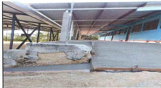
Foto 4: Fundición en Rampa y muro de constención
