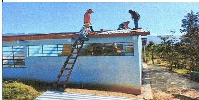
Foto 2: Colocación de Primera Lamina
