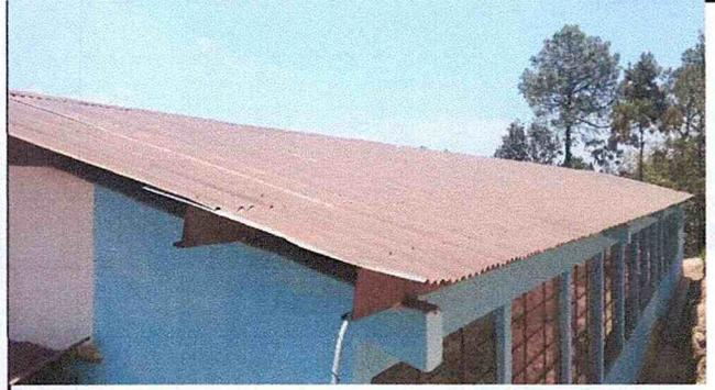
Foto 2: Lámina con corrosión derivado de clima y tiempo transcurrido
