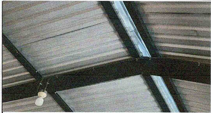
Foto1: Techado finalizado de las 3 aulas.
