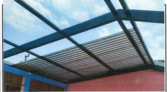
Foto 3: se empieza a colocar el techo nuevo de las aulas.
