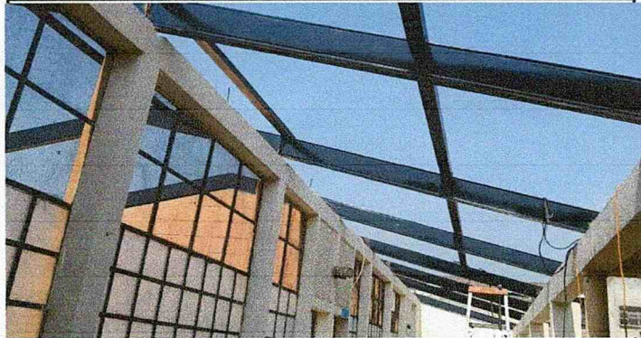
Foto1: Se tira las laminas en su totalidad, como tambien la estructura de soporte.
