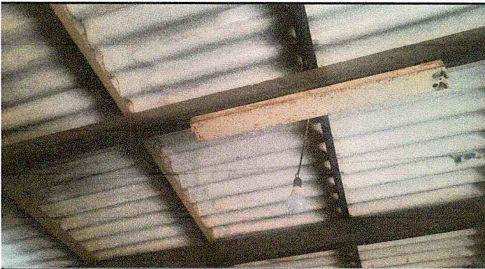
17. REPARACION DE SISTEMA ELECTRICO.
