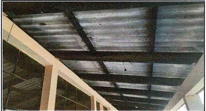
2. ESTRUCTURA DE TECHO. 2.2 Sustitución de de estructura de soporte de madera por metal.
