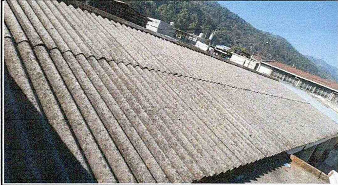
1. CUBIERTA DE LAMINA. 1.2 Sustitución de capote de lámina para lamina troqueda.
