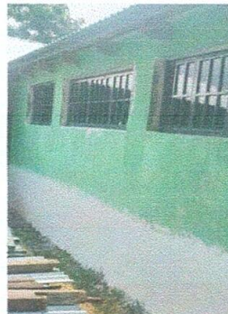
Foto 2: repello de muro
