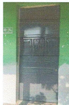
Foto 4: Sustitución de puertas
