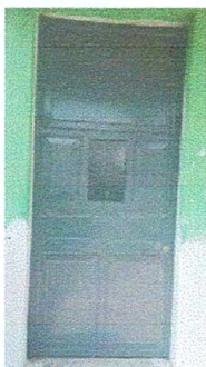
Foto 3: sustitución de puertas
