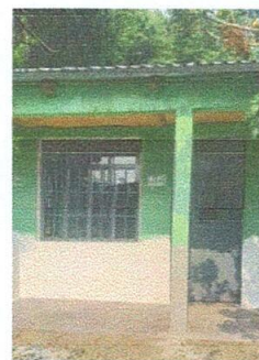
Foto 6: repello de muro, sustitución de puertas y ventanas
