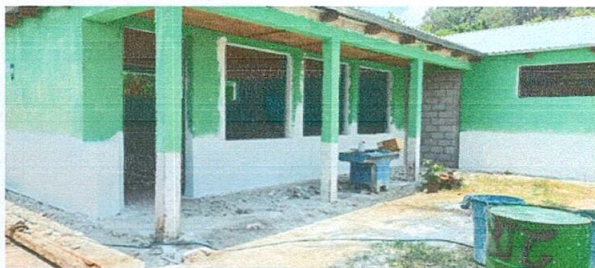
Foto 5: repello de muro, sustitución de puertas y ventanas
