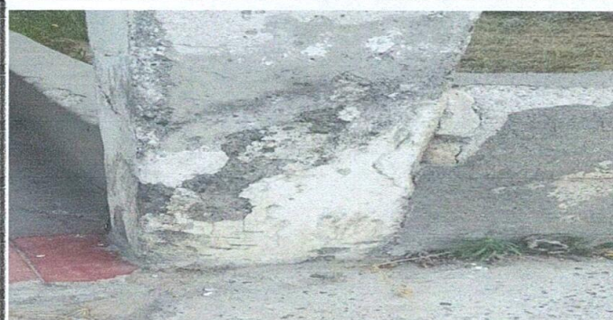
Foto 5: repello en muro
