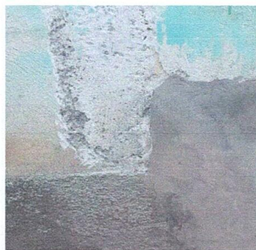
Foto 4: repello de muro
