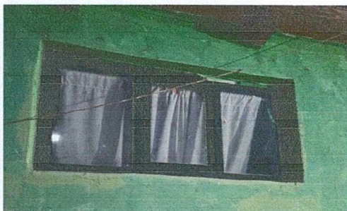
Foto 3: sustitución de ventanas de madera por metal más vidrio
