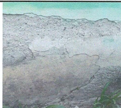
Foto 6: Repello en muro
