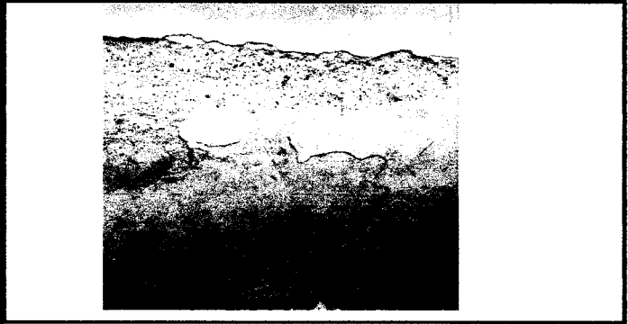
Foto 6: Repello en muro
