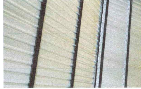
Foto 2: sustitución de estructuras de soporte
