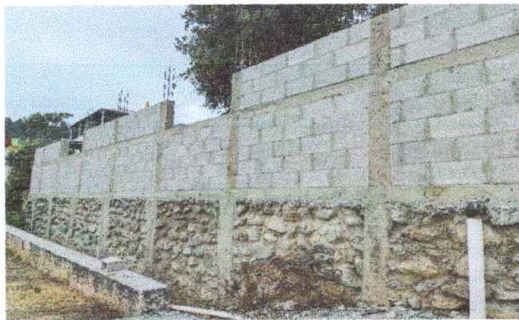
Foto 3: reparación de muro perimetral
