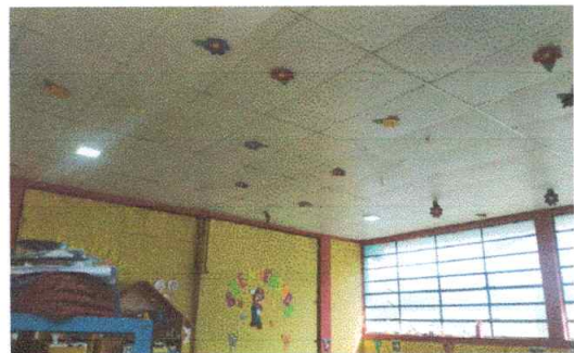
Foto 4: reparación de sistema eléctrico
