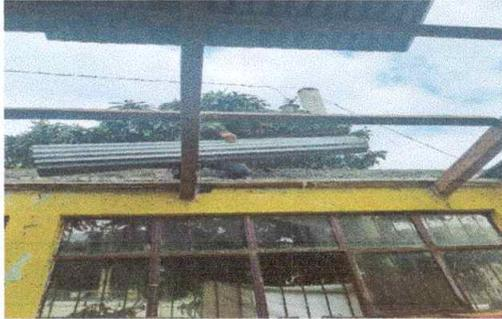
Foto 1: lámina en malas condiciones
