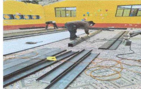
Foto 2: sustitución de estructuras de soporte
