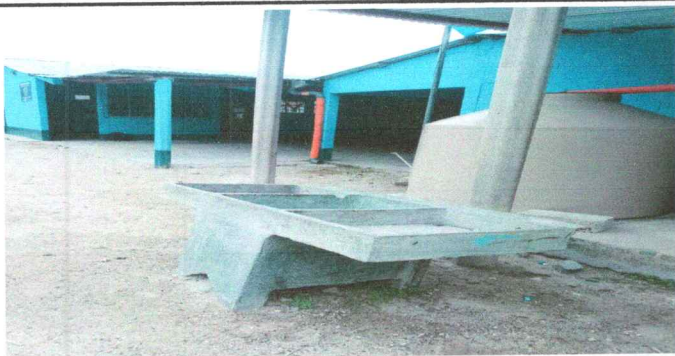
Foto 5: Sustitucion de pila de dos lavaderos
