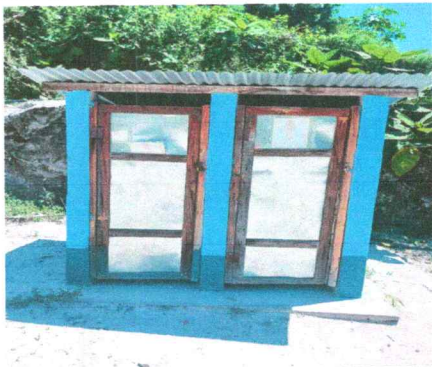
Foto 3: Sustitución de puertas de metal en sanitarios
