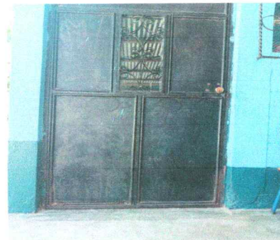
Foto 6: Sustitución de puerta de metal
