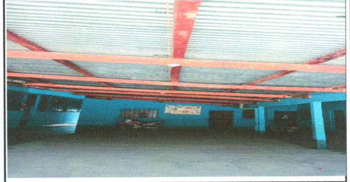
Foto 2: Sutitucion de Estructura de soporte de madera por metal
