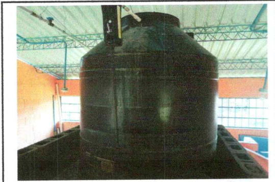
Fotografía 7: Cambio de tinaco, depósito de agua
