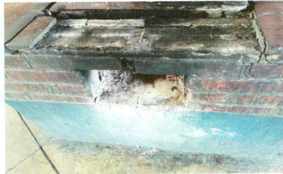
Foto 6: Sustitucion de base para plancha de estufa rural
