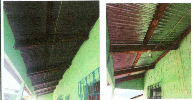
Foto 2: Sustitución de costanera de madera por tubos de metal
