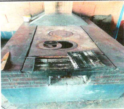
Foto 5: COCINA- Sustitucion de plancha
