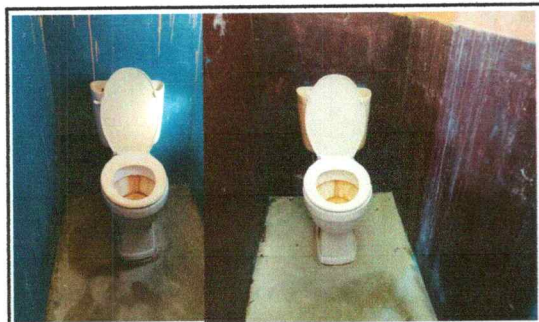
Fotografía 9. sustitución de torta de concreto en baños.
