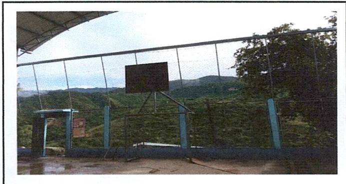
Foto 4. Finalización de la circulación de la malla.
