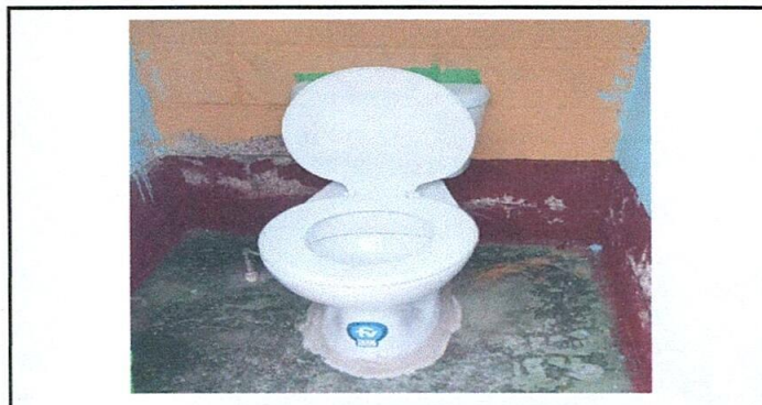
Foto 6. Nueva instalación de inodoros.
