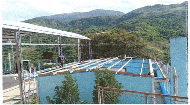
Foto 2. Sustitución de láminas de 1 aula y cocina
