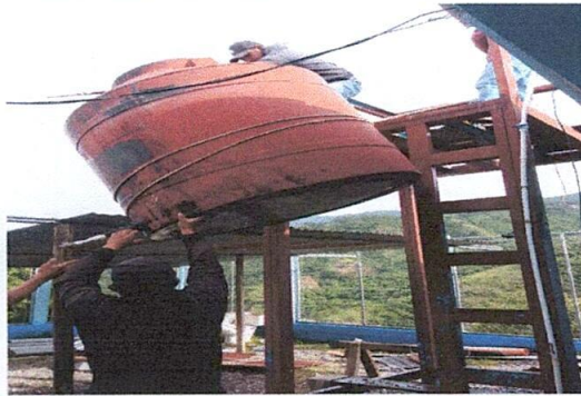
Foto 3. Sustitución de cisterna de agua.
