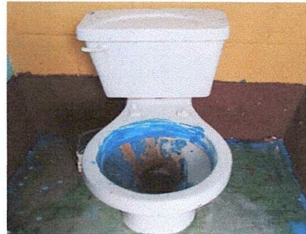
Foto 6. Sustitución de inodoros.
