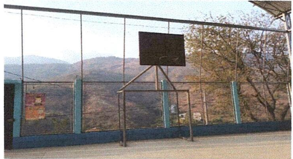
Foto 4. Sustitución de malla.
