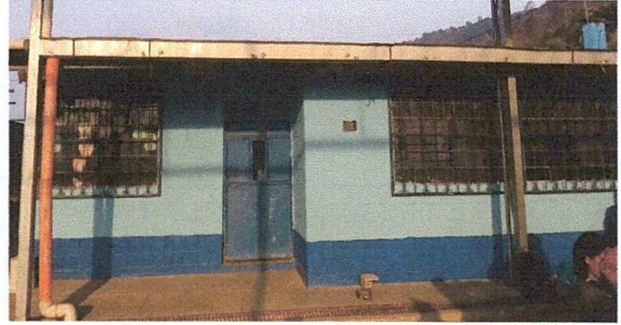
Foto 2. Sustitución de láminas de 1 aula y cocina
