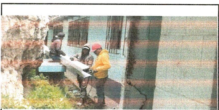
Foto 6: Sustitución de canales galvanizadas cuadrados para bajada de agua
