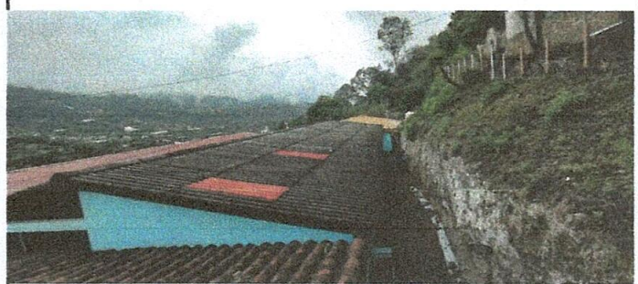
Foto 2: Sustitución de lámina duralita por lámina troquelada
