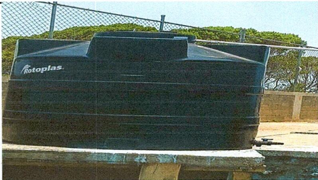
Foto 5. renglón finalizado de usustitución de depósito de agua
