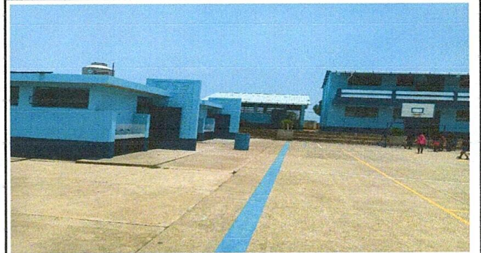
Foto 4: renglón finalizado de pintura de muros exteriores e interiores,
