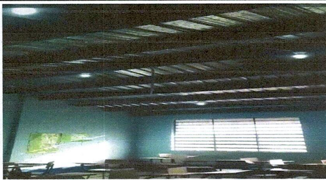
Foto 3: renglón finalizado de sustitución de lámparas por plafoneras y focos led.
