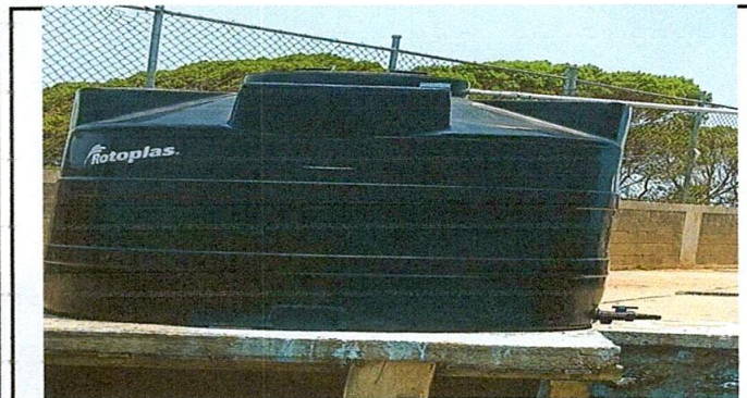
Foto 5: reemplazando el tinaco adherido
