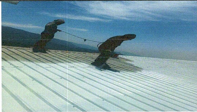
Foto 1: trabajadores contratados pintando el techo del edificio
