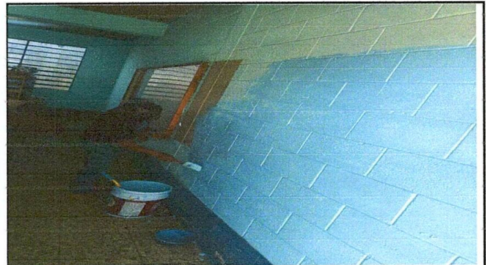
Foto 5: padres de familia en el pintado del edificio escolar
