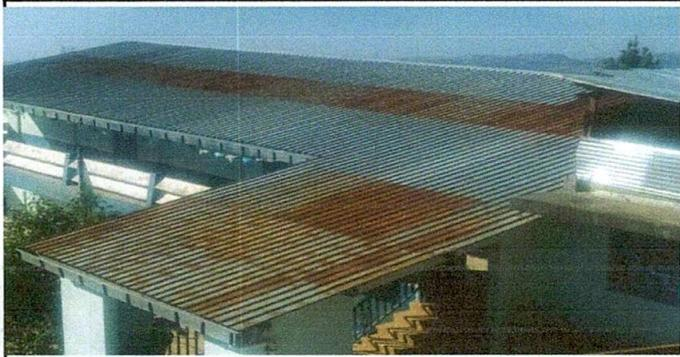
Foto 1: techo de lámina estructural con Oxido por custiones climáticas
