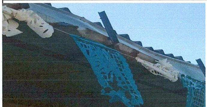
Foto 2: Canales de todo el edificio escolar picados y en mal estado.
