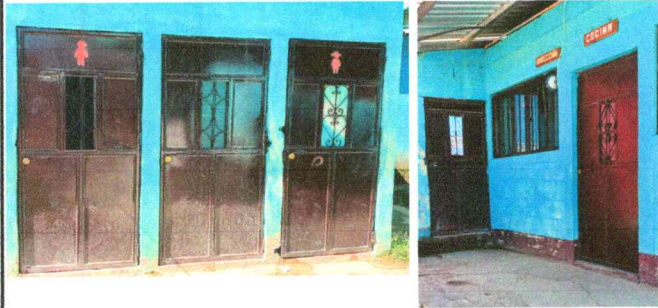
Foto1: Mantenimiento de puertas
