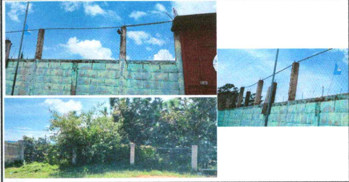
Foto 6: Sustitución de malla y tubos en muro perimetral
