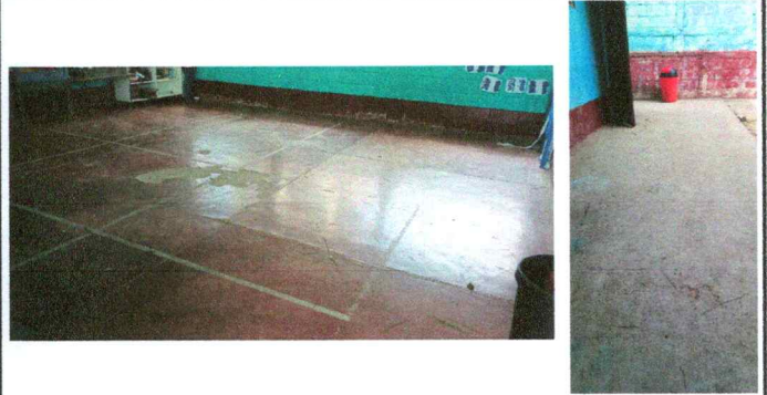
Foto 2: SUSTITUCION DE PISO DE CEMENTO LIQUIDO (A PISO DE GRANITO)
