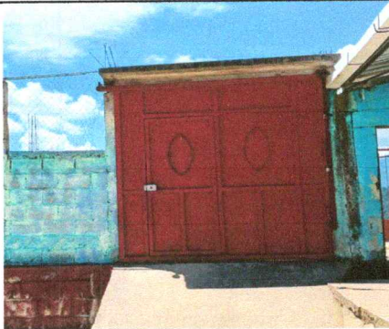
Foto 5: Mantenimiento de portones
