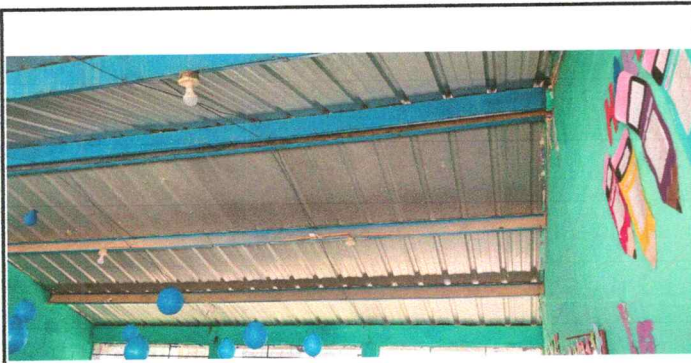
Foto7: Reparación de sistema eléctrico
