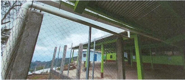
Foto 15: Finalización de Canales y Bajadas de Agua Pluvial
