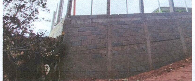
Foto 14: Finalización de Reparación de Muro de Contención
