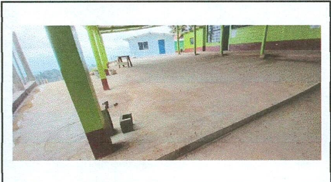
Foto 2: Finalización de Reparación de Piso de torta de concreto
