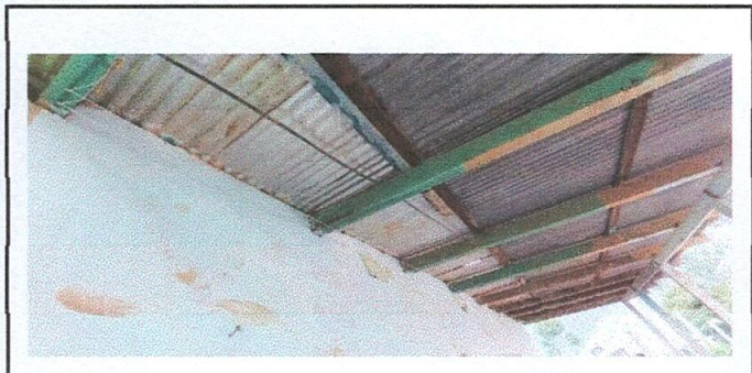
Foto 9: Finalización de Reparación de Sistema Eléctrico
