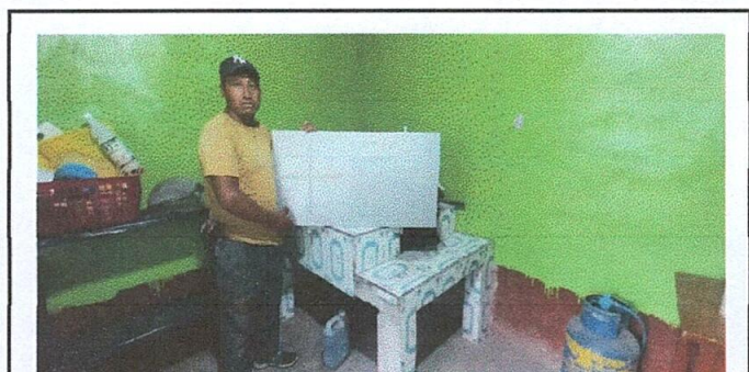
Foto 12: Finalización de Reparación de cocina
