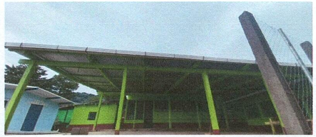
Foto 16: Finalización de Canales y Bajadas de Agua Pluvial
