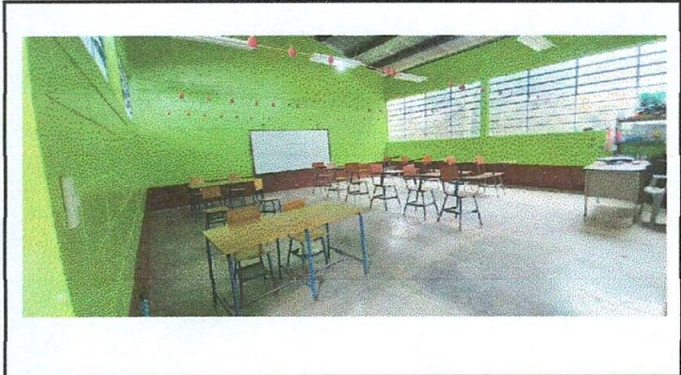
Foto 4: Finalización de Pintura de muros exteriores e interiores
