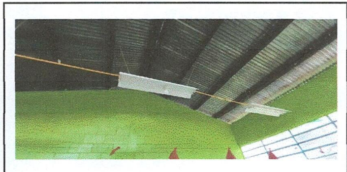
Foto 10: Finalización de Reparación de Sistema Eléctrico
