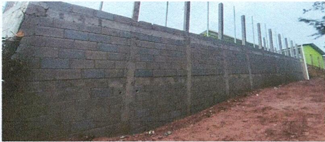
Foto 13: Finalización de Reparación de Muro de Contención
