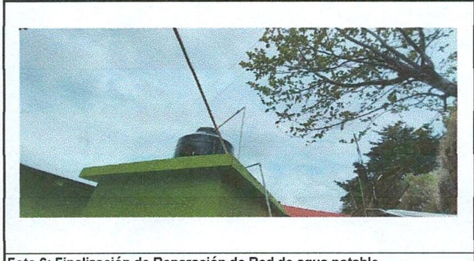
Foto 6: Finalización de Reparación de Red de agua potable
