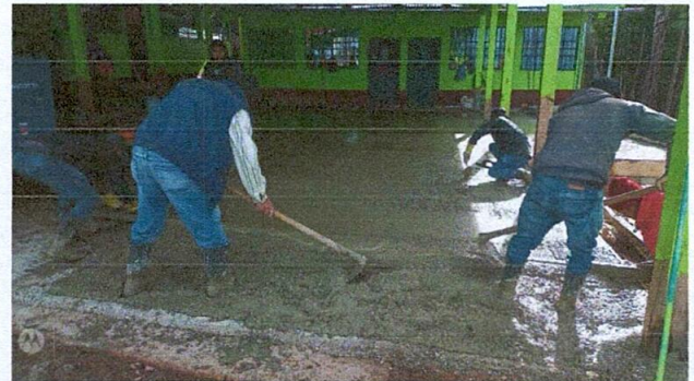
Foto 2: Proceso de Reparación de Piso de torta de concreto
