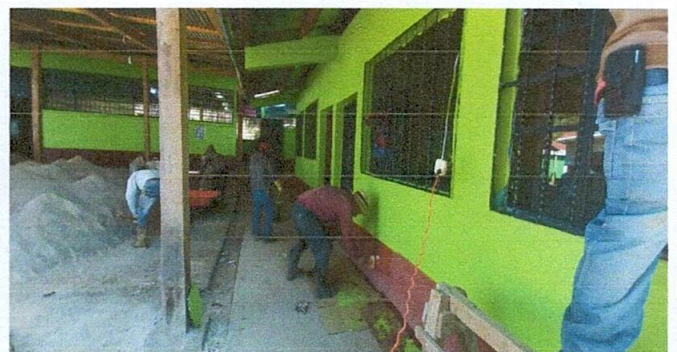
Foto 4: Proceso de Pintura de muros exteriores e interiores
