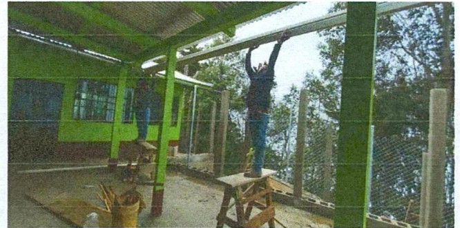
Foto 16: Proceso de Canales y Bajadas de Agua Pluvial
