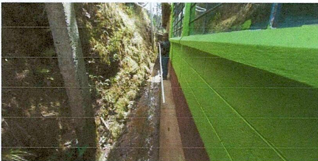
Foto 5: Proceso de Reparación de Red de agua potable
