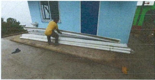
Foto 15: Proceso de Canales y Bajadas de Agua Pluvial
