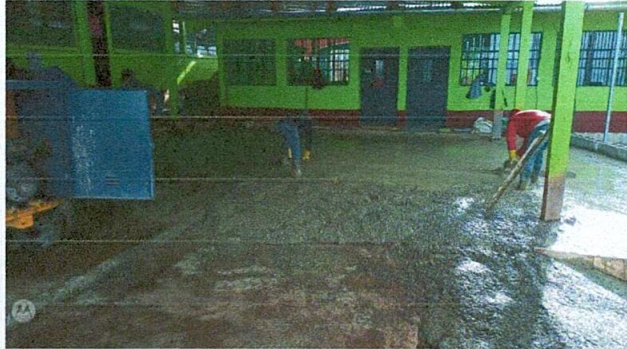
Foto 1: Proceso de Reparación de Piso de torta de concreto
