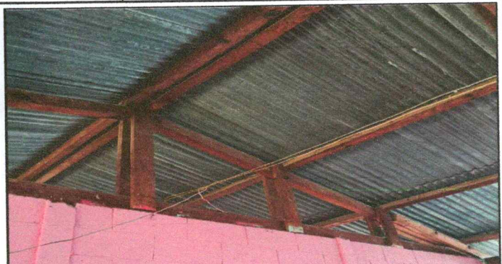
Foto 2: SUSTITUCIÓN DE SOPORTE DE MADERA POR ESTRUCTURA DE METAL DE TECHO
