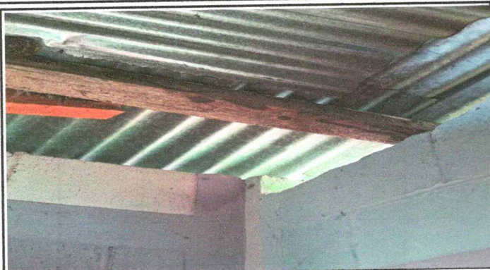
Foto1: SUSTITUCIÓN DE LAMINA
