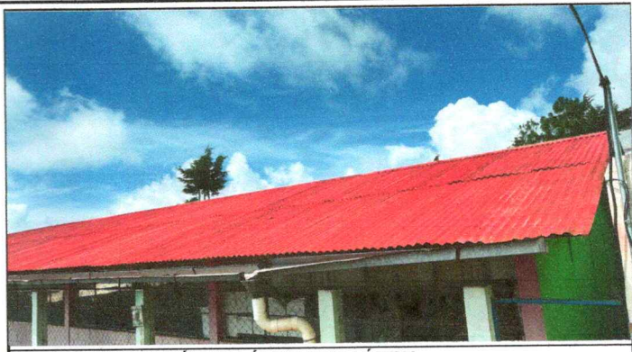
FOTO 2: SUSTITUCIÓN DE LÁMINA POR LÁMINA
