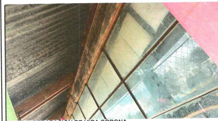
FOTO 5: REPARACION DE VIGA CORONA
