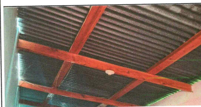
Foto 5: SUSTITUCIÓN DE FOCOS AHORRADORES
