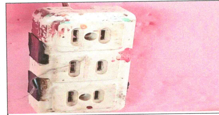
Foto 6: SUSTITUCIÓN DE TOMACORRINETES
