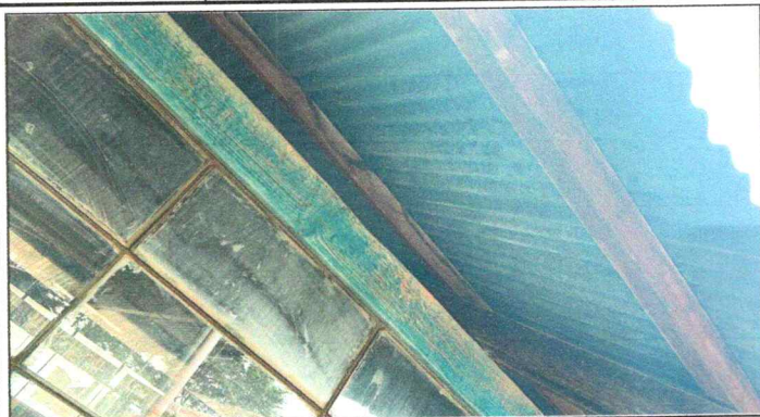
FOTO 1: SUSTITUCIÓN DE LAMINA POR LAMINA
