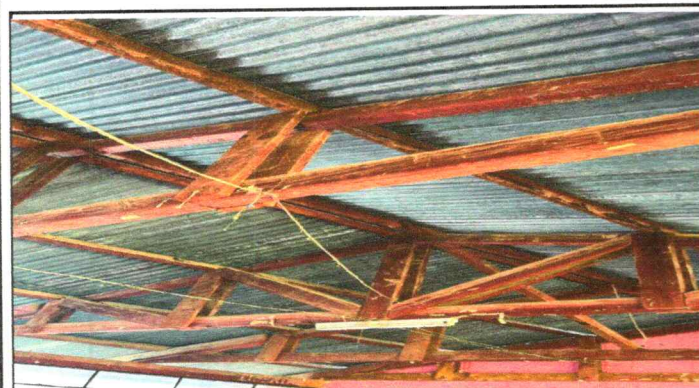
FOTO3: SUSTITUCION DE VIGAS DE MADERA POR METAL
