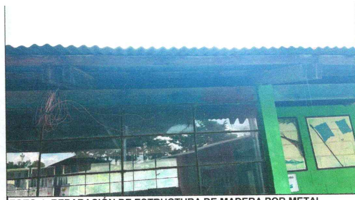
FOTO 4: REPARACIÓN DE ESTRUCTURA DE MADERA POR METAL
