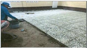
Foto 3: Sustitución de piso, por granito en proceso.
