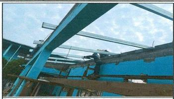
Foto 2: Arregio de pared para sosten del techado.
