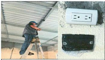
Foto 4: Colocación de cabliado de energía electrico y accesorios.
