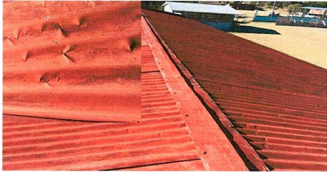
Foto 1: cambio de techo de aulas.
