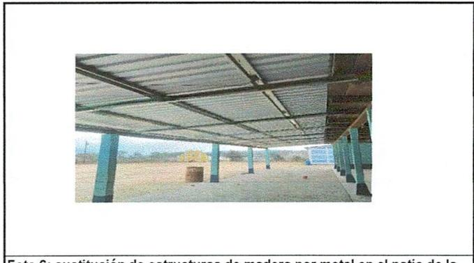
Foto 6: sustitución de estructuras de madera por metal en el patio de la escuela
