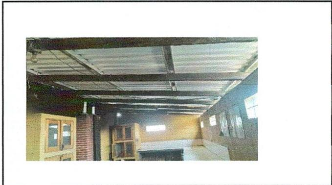
Foto 4: sustitución de láminas troqueladas aluzinc en techo de la cocina
