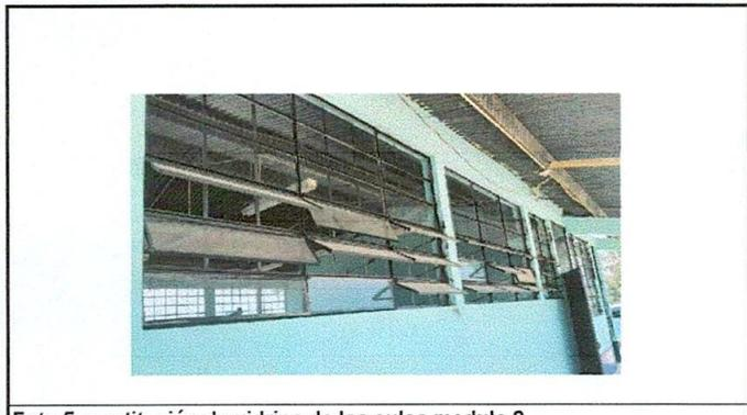
Foto 5: sustitución de vidrios de las aulas modulo 2
