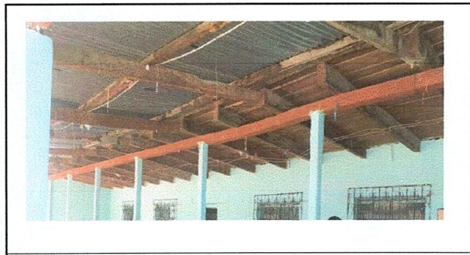
Foto 5: Sustitución de estructura de madera por metal en el corredor
