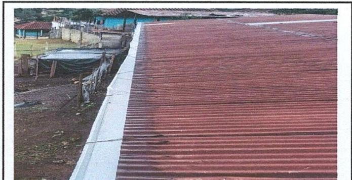
Foto: Sustitución de canal
