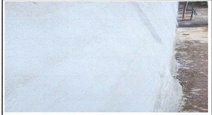
Foto 2: Sustitución de repello
