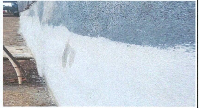
Foto 2: Sustitución de repello
