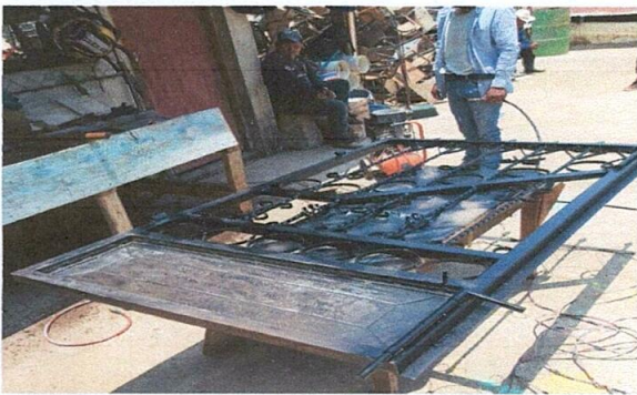
Foto 5: Mantenimiento a portón de metal
