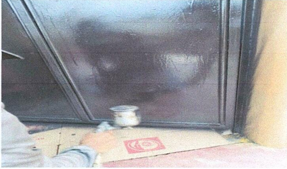
Foto 1: Mantenimiento a estructura (lijado, aplicación de pintura)
