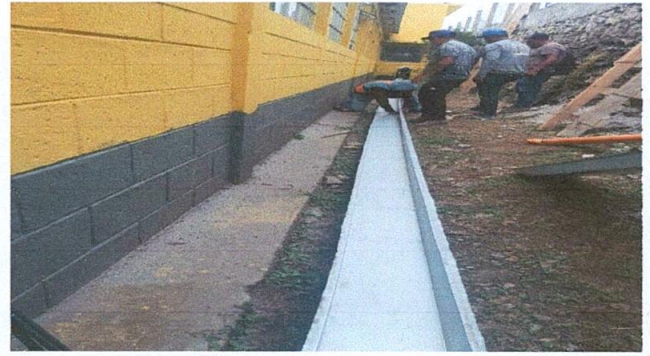
Foto 6: sustitución de canal de pvc
