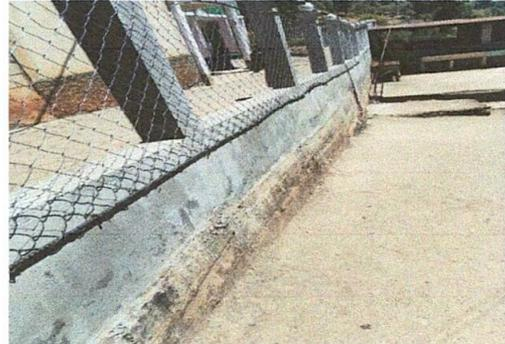
Foto 2: Sustitución de repello
