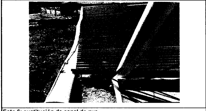
Foto 6: sustitución de canal de pvc
