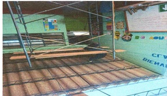
Foto 4: Sustitución de lamina troquelada.
