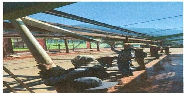
Foto 6: Sustitución de canal de metal.
