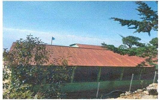
Foto 2: Sustitución de capote de lamina por lamina troquelada.
