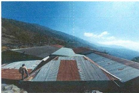
Foto 5: Sustitución de lamina por lamina troquelada.
