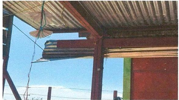
Foto 4: sustitución de canal de metal.
