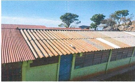
Foto1: Sustitución de capote de lamina por lamina troquelada.
