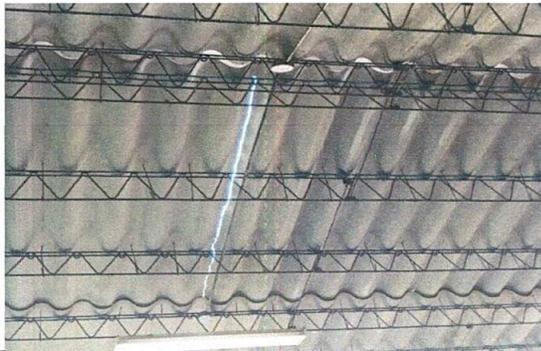
Foto 3: Sustitución de lamina troquelada.
