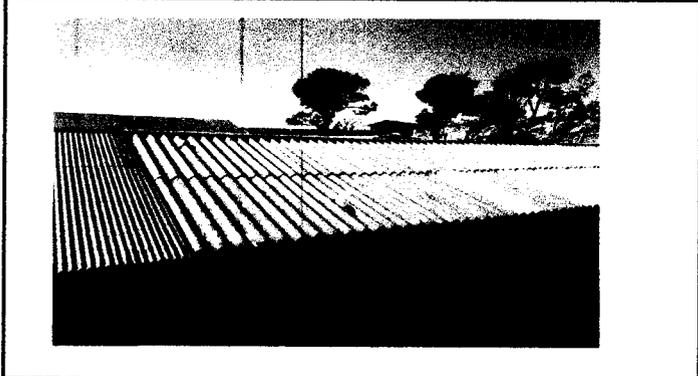
Foto 1: Sustitución de capote de lamina por lamina troquelada.
