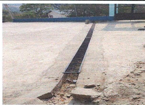
Foto 6: Cunetas de concreto
