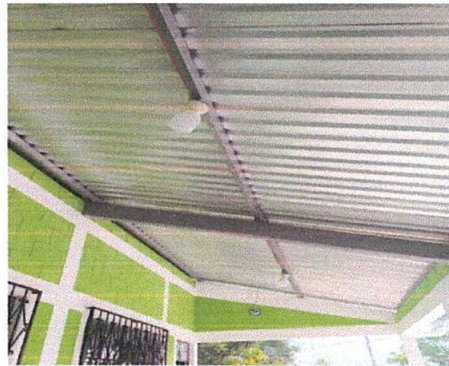
Foto 2: Estructura de techo
