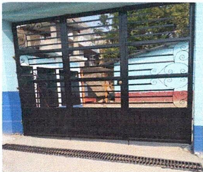
Foto 3: Puertas de metal
