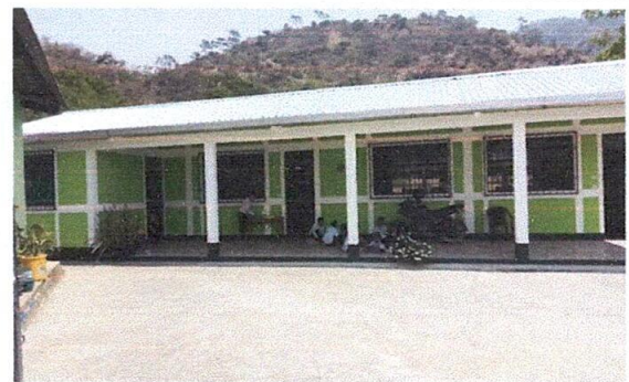
Foto 10: Mano de obra de albañilería, electricidad y plomería
