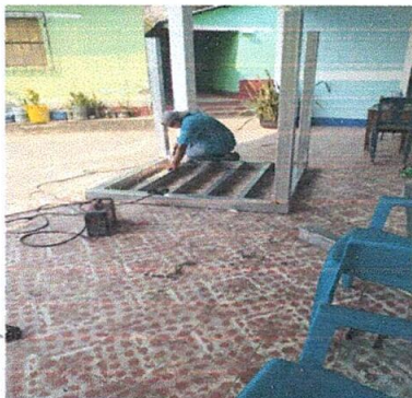
Foto 3: Reparación y mantenimiento de sistema/Depósito de Agua
