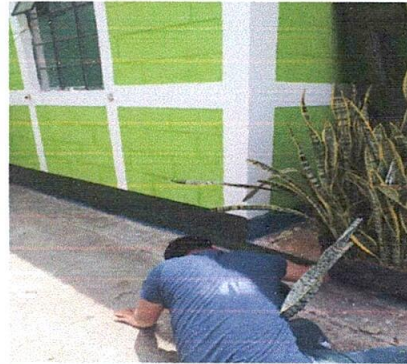
Foto 4: Pintura en muros exteriores e interiores
