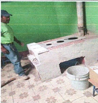
Foto 5: Reparación de Cocina
