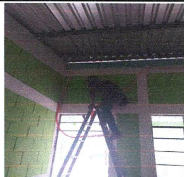
Foto 6: Reparación de sistema eléctrico
