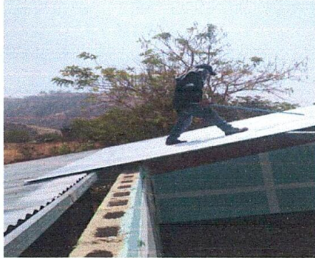
Foto 1: Cubierta de lámina
