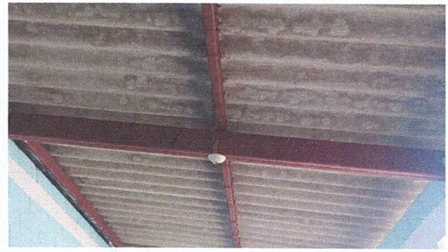
Foto 8: REPARACIÓN DE SISTEMA ELÉCTRICO
