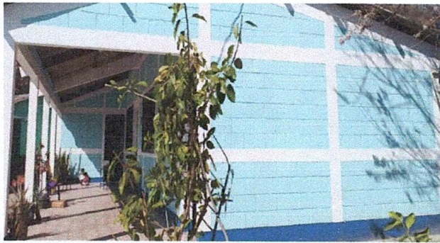
Foto 7: PINTURA EN MUROS EXTERIORES E INTERIORES
