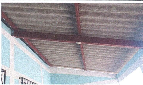
Foto 2: ESTRUCTURA DE TECHO
