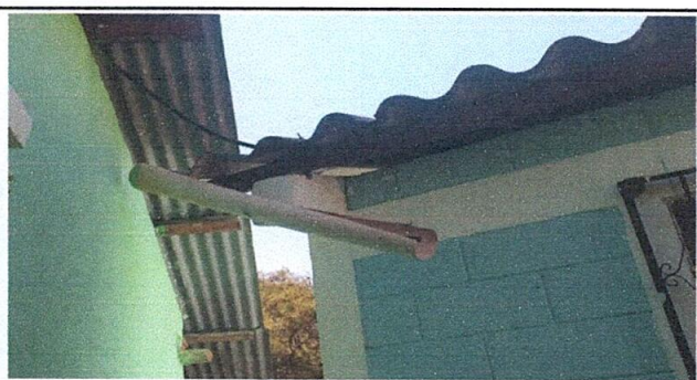
Foto 5: CANALES Y BAJADAS DE AGUA PLUVIAL
