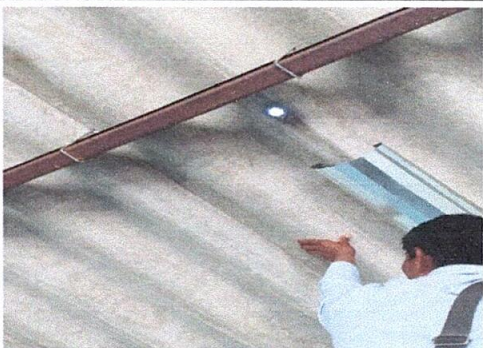
Foto 1: CUBIERTA DE LÁMINA
