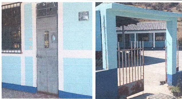
Foto 3: PUERTAS DE METAL
