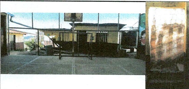
Sustitución de Porton
