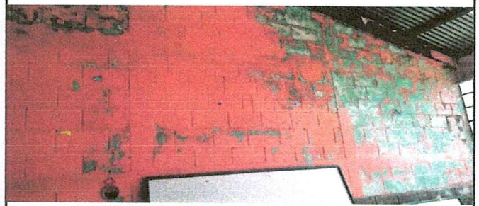
Mejoramiento de pared 2 con filtración de agua con impermeabilizante superior.
