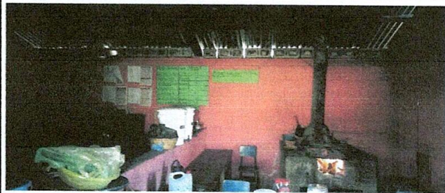
Mejoramiento de cocina, colocación de tres planchas, colocación de tres ventanas, ampliación de espacio.
