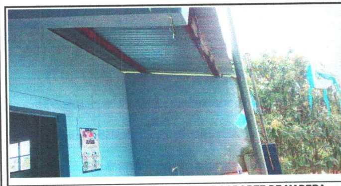
FOTO 5: SUSTITUCION DE ESTRUCTURA DE SOPORTE DE MADERA POR METAL
