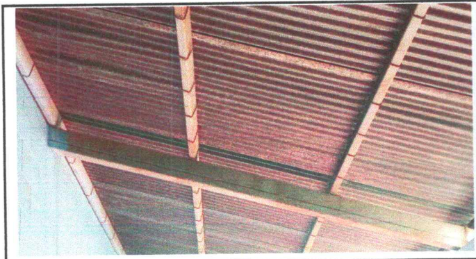
FOTO 3: SUSTITUCION DE ELEMENTOS DE FIJACION
