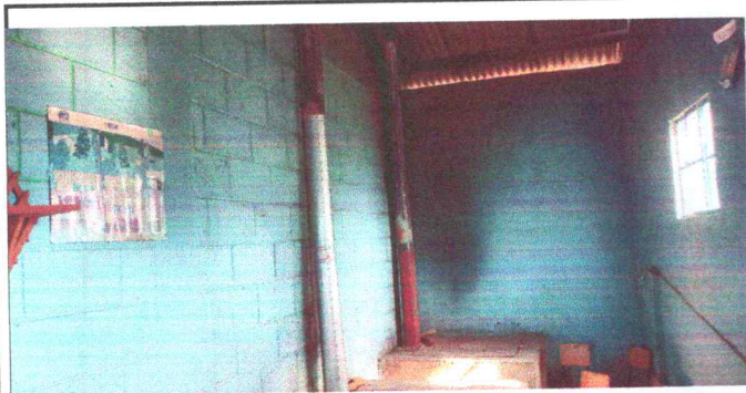
FOTO 9: SUSTITUCION DE CHIMENEA DE METAL, POR CHIMENEA DE MATA
