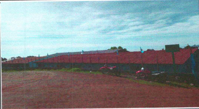
FOTO 1: SUSTITUCIÓN DE LAMINA POR LAMINA TROQUELADA
