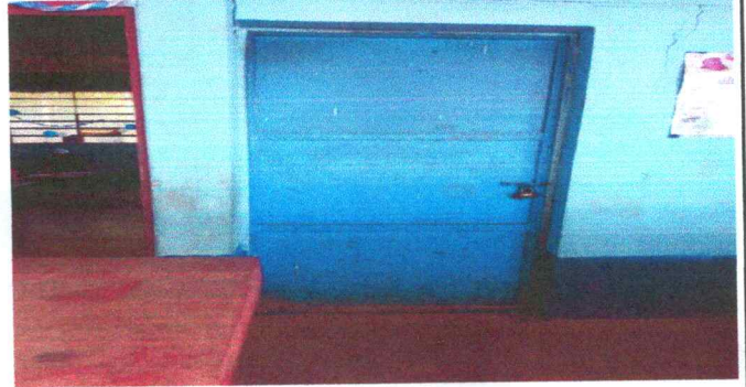
FOTO 8: PINTURA Y LIJADO DE FUERTA DE METAL
