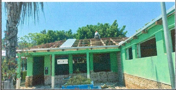
Foto 1: El techo en construcción es un collage de materiales diversos que se unen en armonía para crear una estructura en evolución.
