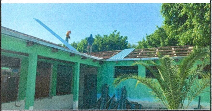
Foto 4: Entrelazadas entre estos elementos, las vigas metálicas agregan un toque de modernidad y resistencia.
