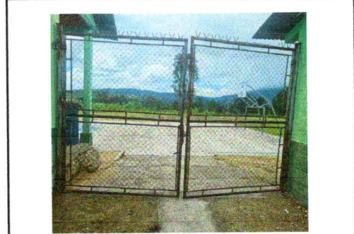
Foto : Sustitución de portón de metal de ingreso
