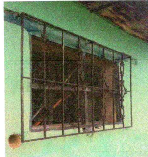
Foto 4: Sustitución de balcón de ventana
