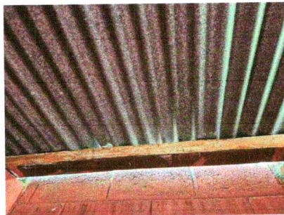
Foto 5: sustitución de estructura de soportede madera, por metal
