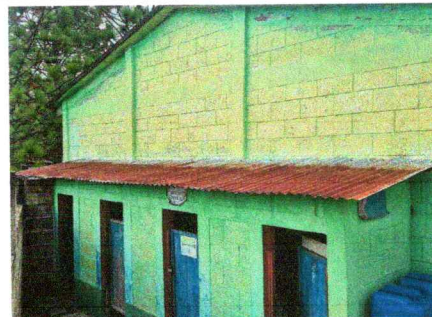
Foto 6: Sustitución de lámina, por lámina troquelada aluzinc calibre 26
