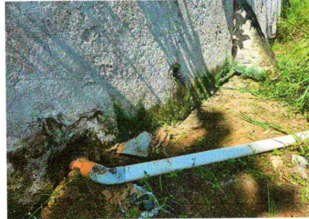
Foto 2: Sustitución de tubería PVC línea principal de aguas negras
