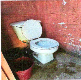
Foto 1: Sustitución de inodoro
