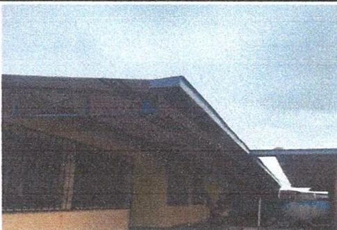
Foto 5: Colocación de canal de metal en modulo 1 y 2
