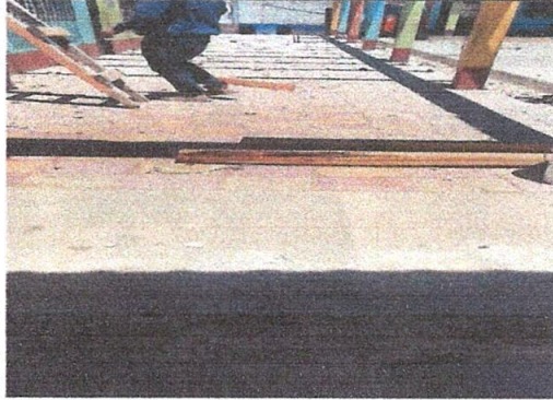
Foto 1: Desmontando el techo
