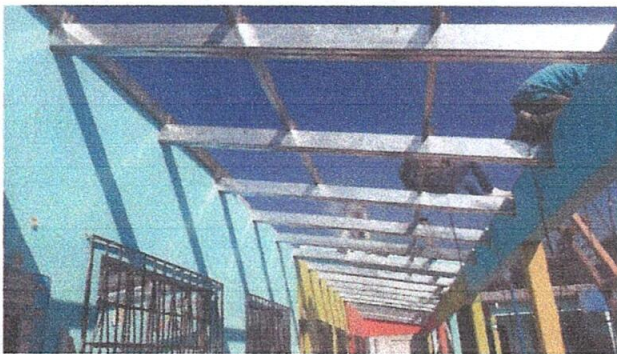
Foto 5: Colocando Estructura Metálica
