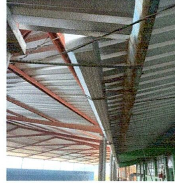
Foto 2: instalado el canal de agua
