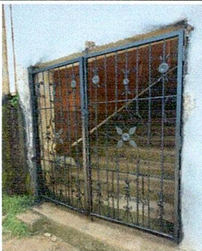
Foto 5: mantenimiento de porton
