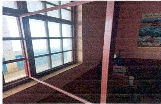
Foto 2: cambio de vidrios
