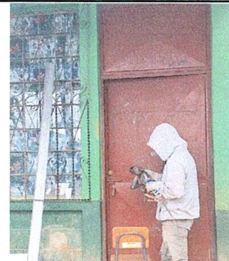
Foto 6: inicio de mantenimiento de puerta
