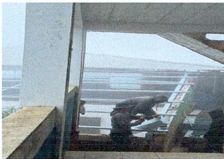
Foto 5: colocando capote de metal saion
