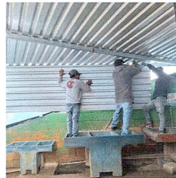
Foto 4: poniendo lamina salon
