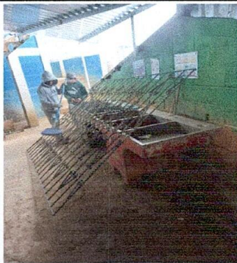
Foto 3: inicio mantenimiento balcon
