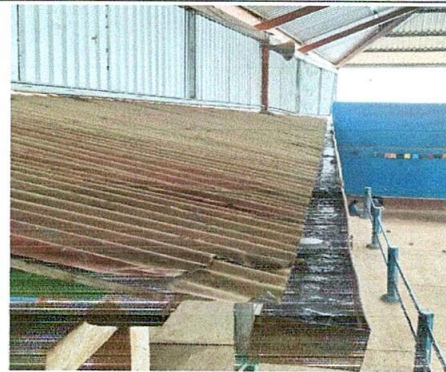
Foto 4: reparacion de bandeja de agua
