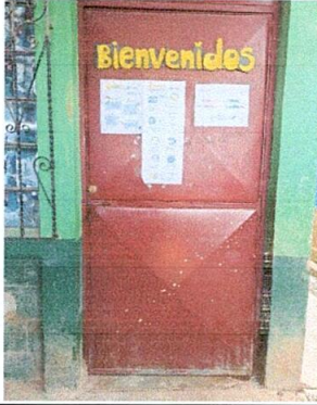
Foto7: mantenimiento de puerta
