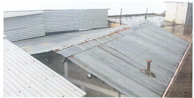
Foto12 : Sustitución de iamina cocina
