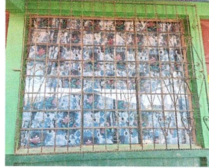
Foto 8: mantenimiento de balcon
