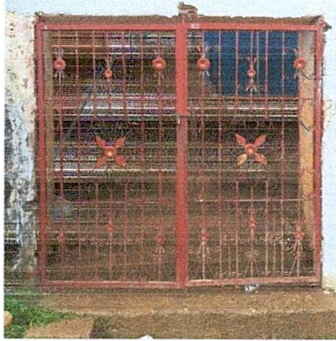
foto 9: mantenimiento de porton
